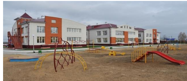
Комплексная застройка село Шыгырдан (Батырьевский район)
